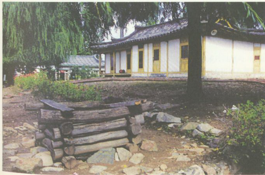
此图前部地面上的砌木为井干式民居墙体造型
