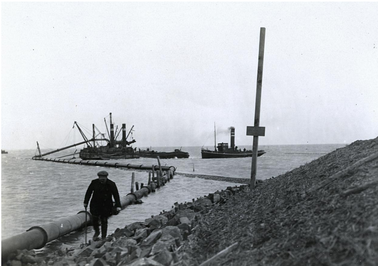
Fig 2. The construction of the Afsluitdijk. (Source: https://beeldbank.rws.nl , Rijkswaterstaat)
