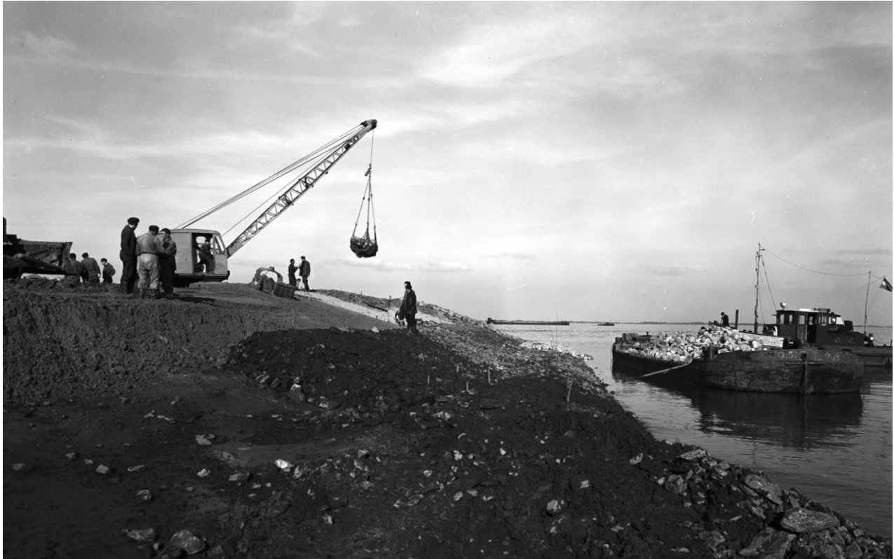
Fig 1. The construction of the Volkerkadam. (Source: https://beeldbank.rws.nl , Rijkswaterstaat)
